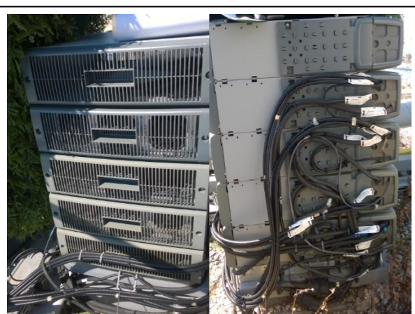
Figure 4 : Baie Flexi Multiradio BTS Nokia
